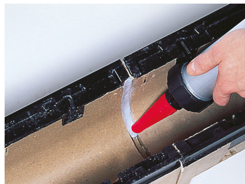
Utilice sellador compatible (Sikaflex 11FC), una vez colocado el relleno envolvente.
